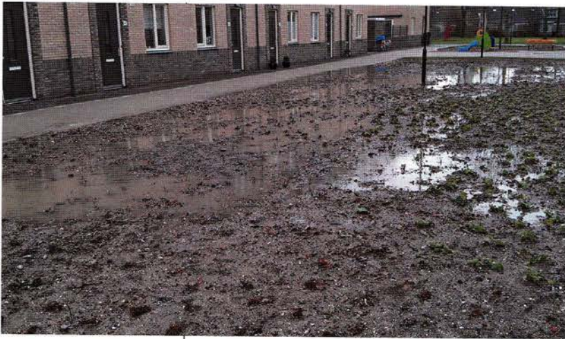
Een voorbeeld van slechte voorbereiding van de grond. Bouwpuin en wortelonkruid zijn niet verwijderd en, gezien de hoeveelheid water op het vak, is er sprake van een storende laag. Deze beplanting is hoogstwaarschijnlijk op voorhand verloren.
