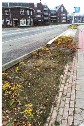
▲ Rijksweg Zuid Swakmen voor aanleg
