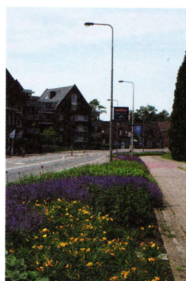
▲ Rijksweg Zuid Swakmen 3 maanden na aanleg
