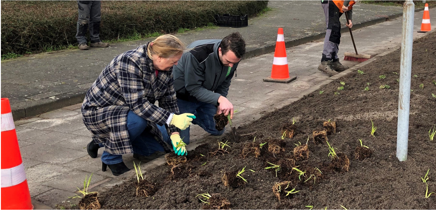
Wethouder Wilma Alink langs bij de werkzaamheden op de kruising Hoofdweg en Voltastraat
