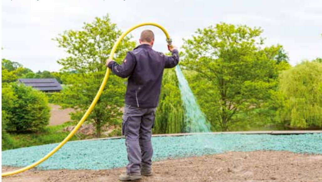
Hydroseeding wordt met een brandweerspuit aangebracht
